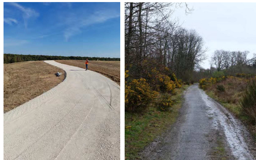
Figure 7 : Voie périphérique de la centrale photovoltaïque de Vendôme (une réalisation IEL) (gauche), Photo de la voie existante sur le site d'Aucaleuc (droite)
